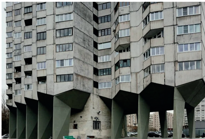
Рис. 1. Дом по адресу: Новосмоленская набережная, д. 6
